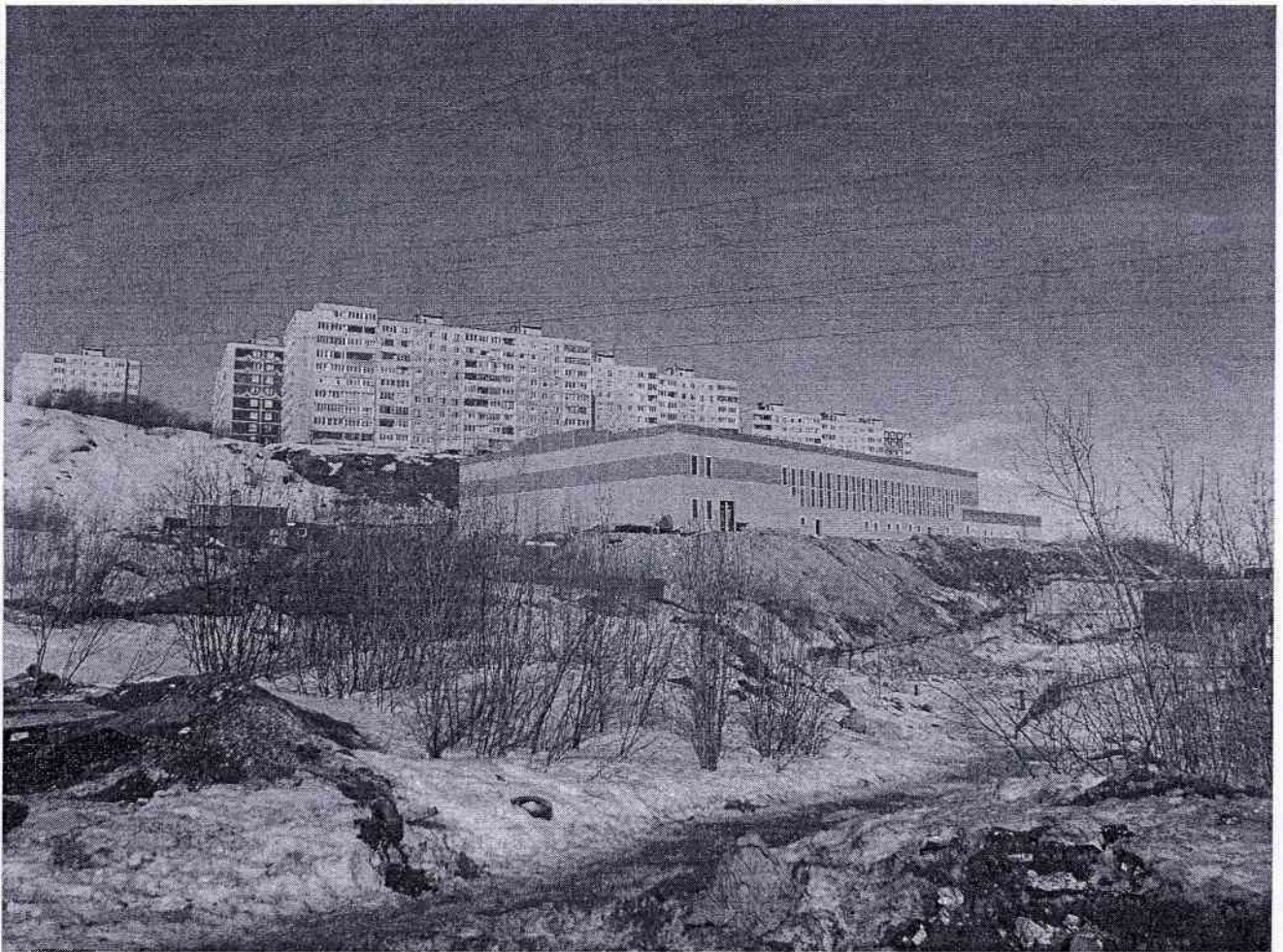
- общий вид строительной площадки с улицы Полярный круг
