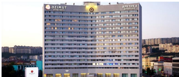
Реконструкция гостиницы «Арктика»
