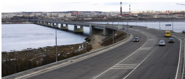
Мост через Кольский залив
