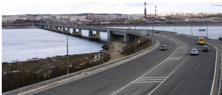
Мост через Кольский залив
