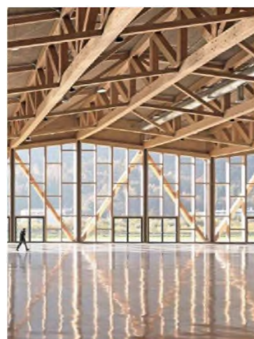
Наклонные колонны в зале с бассейном
