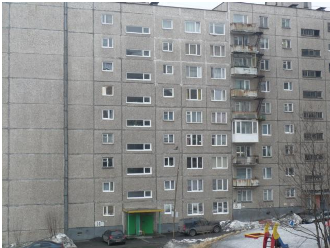
Достоевского, 14. Общий вид дома
