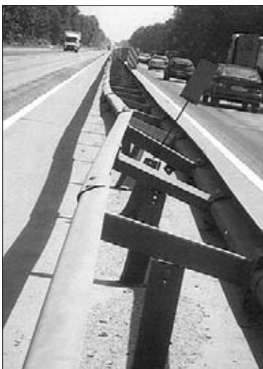
Рисунок 3.2.12 – Иллюстрации этапов работы двустороннего дорожного ограждения
