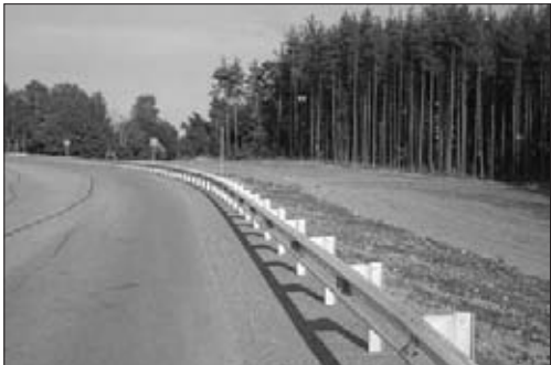
Рисунок 3.2.10 – Пример использования дорожного ограждения
